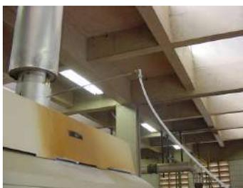
**Figura 6.27 – Detalhe da adaptação feita para a coleta de amostra dos gases de exaustão da microturbina**
