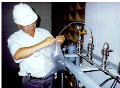
**Figura 6.18 – Coleta de amostra do biogás em saco plástico apropriado, denominado “bag”, no Ponto – 1 (antes do sistema de purificação), na primeira bancada**
